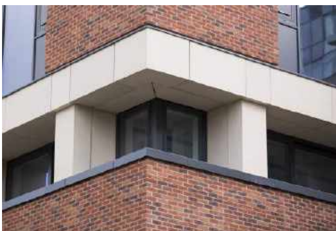
▼ płyty sufitowe i podcieniowe
