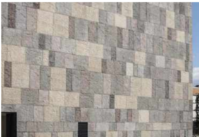
▼ fasada wentylowana ścian zewnętrznych
