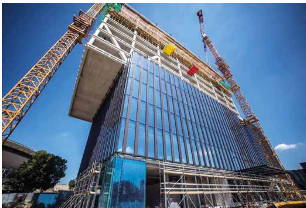
Budynek KTW w Katowicach
